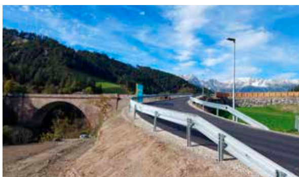
Die neue Zufahrtsrampe auf die Bundesstraße, über welche der Radweg führt und zugleich der Ortsteil Unterberg öffentlich erschlossen wird.
